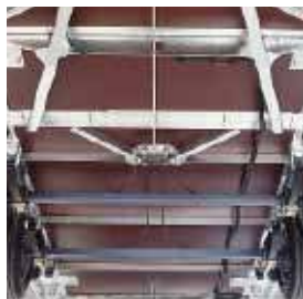
Châssis et plancher
